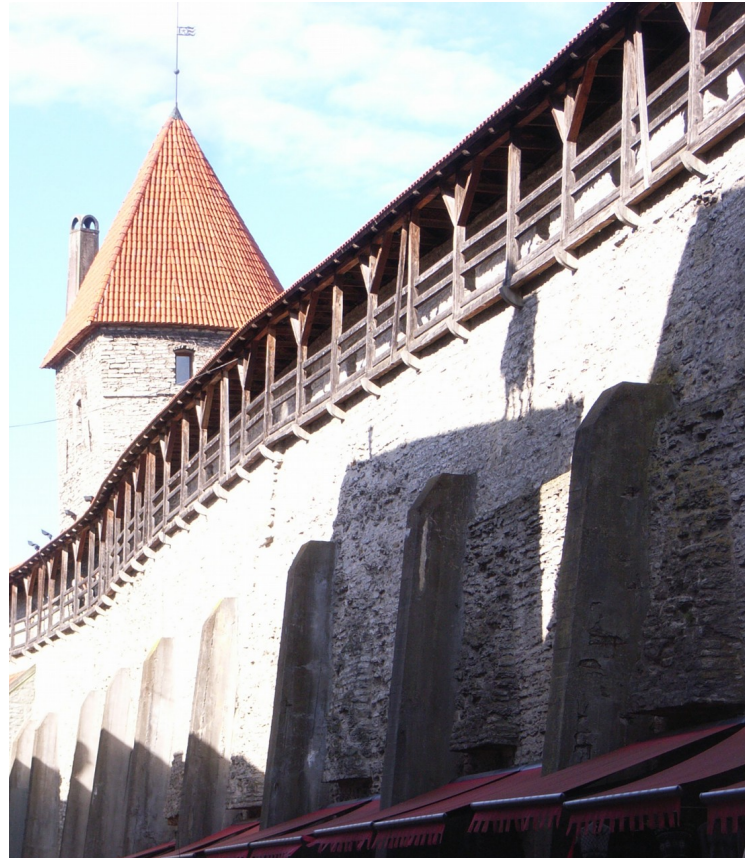
Ein Abschnitt der im Original erhaltenen Stadtmauer
