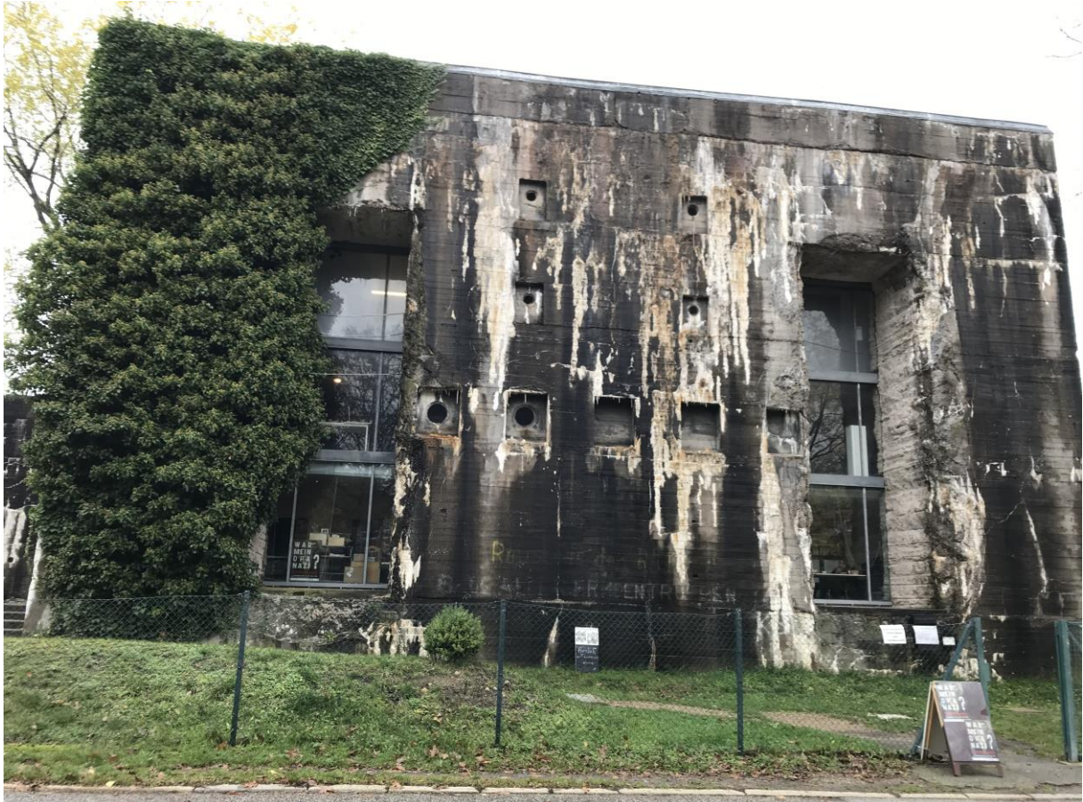
Der Flandernbunker mit seinen Fenstern im dicken Stahlbeton.
